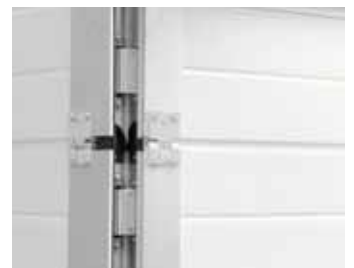
Particolare delle cerniere a scomparsa della porta pedonale (vista interna).
