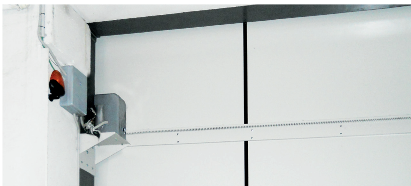
Motorizzazione meccanica a cremagliera completa di motore trifase a 380V applicato in parete.
