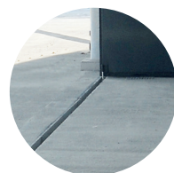
Particolare della guida a pavimento.
